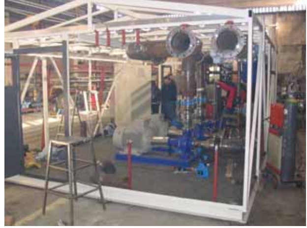
Apulaitekontti asennusvaiheessa TKH Oy:n konepajalla Uudessakaupungissa.
