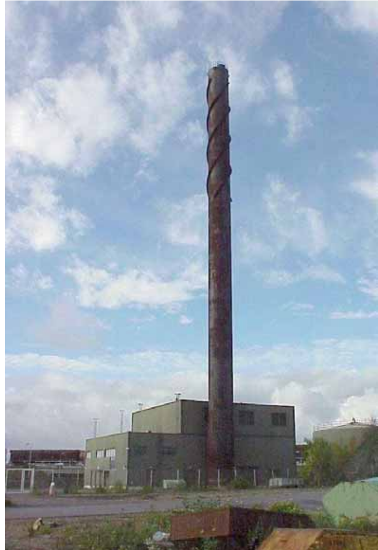
Nekalan kaukolämpökeskuksessa on tehty vaaranarviointi
