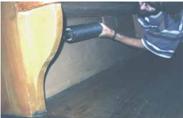
Suunnitteluvaiheessa ripaputkipattereita kokeiltiin kirkonpenkin alle.
