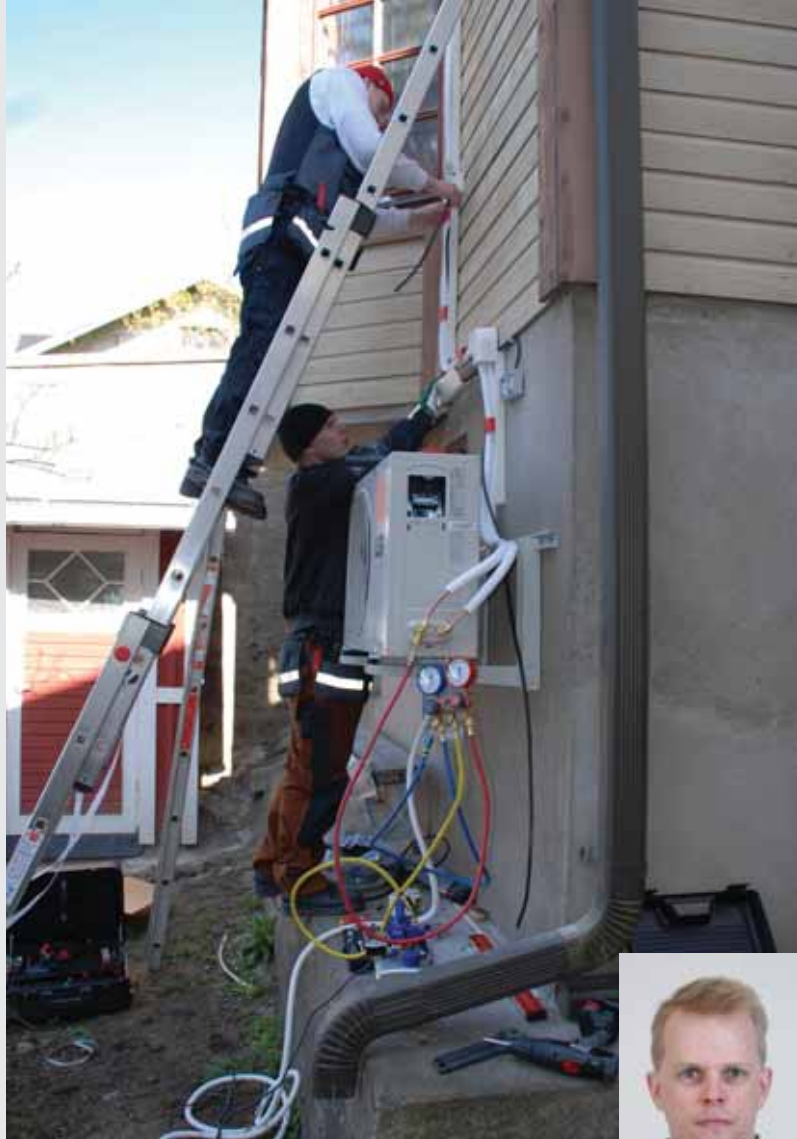
Ulkoyksikön asennus loppusuoralla.
