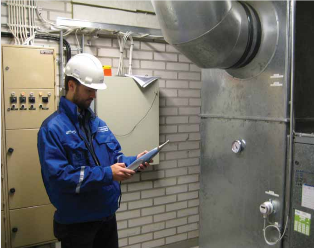
Äänianalysaattorilla määritetään vallitseva äänispektri.
