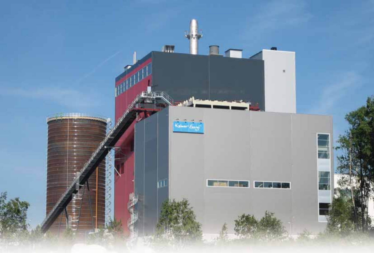
Taka-alalla kaukolämpövesivaraaja, keskellä kattilahuone ja etualalla turbiinitali.
